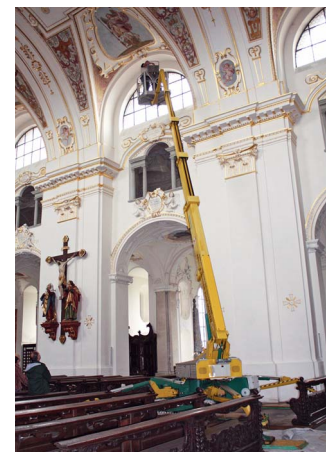
Begutachtung und Kontrolle der Kirchendecke mithilfe der Spinne auf Raupe.
