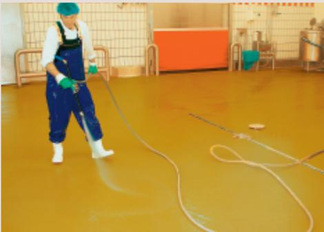
**Die fugenlosen und wasserundurchlässigen Ucrete-Systeme halten intensiven Reinigungsmethoden mit Hochdruck, Heißdampf und aggressiven Chemikalien stand.**
