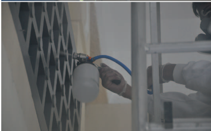
Eine Feinreinigung mit Handvernebelungsgeräten, Tüchern, Schwämmen und feinen Bürsten intensiviert die Säuberung.
