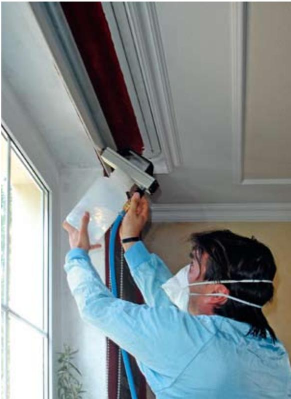
Das System ValloFog enthält auf Guanidinbasis entwickelte kationische Polymere, die sich aufgrund der positiven Teilchenladung stark an Zellwände und Membranen binden. Diese positiv geladenen, langkettigen Moleküle sind chemisch träge, docken so an den
